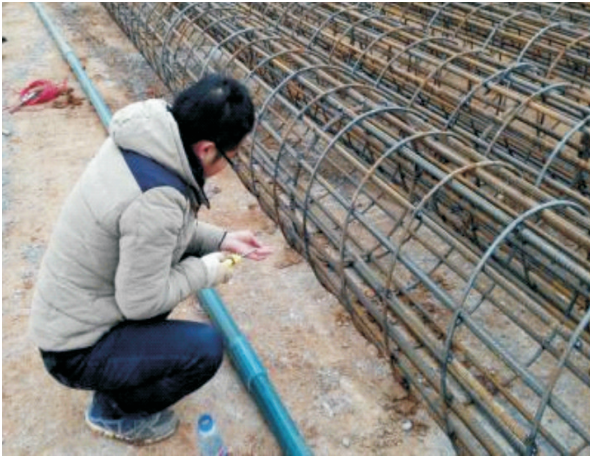
图3 绑扎测斜管 Fig. 3 Binding inclinometer pipe
